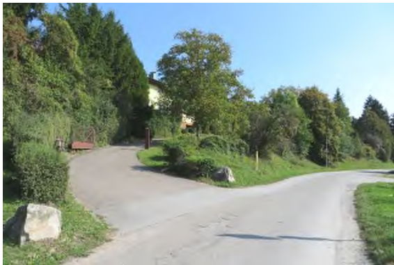
Bild 3: Blick von Westen entlang Straße Am Gaisberg
